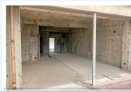
平城第一団地 (奈良県奈良市)
