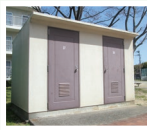
玉川橋団地 (大阪府高槻市)
