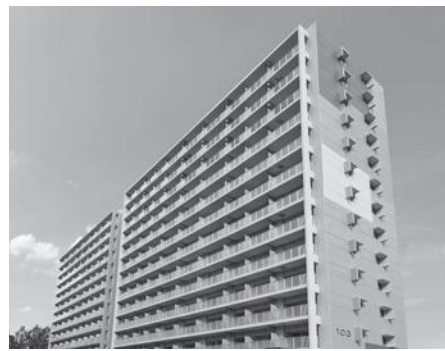
今回募集棟の一部(103・104号棟) ※写真は令和4年11月撮影
