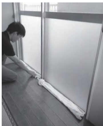
内側からサッシの敷居部分をタオルなどで抑えるとさらに効果的です。
