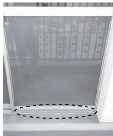
建具(窓枠)下部に外側から養生テープを貼り付けます。
