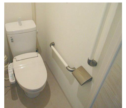
手すりを2カ所に設置したトイレ(高齢者世帯向け)
