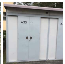
屋外スチール製倉庫
