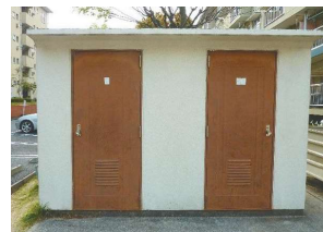
屋外鉄筋コンクリート倉庫
