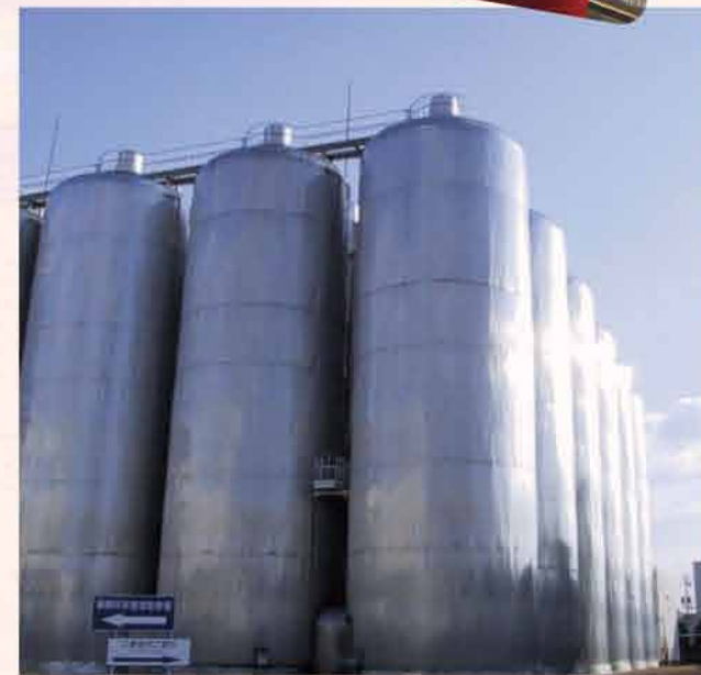
高さ20mの屋外タンクの容量は350ml缶110万本分。ここで数10日間発酵と熟成をさせ美味しいビールが生まれる
