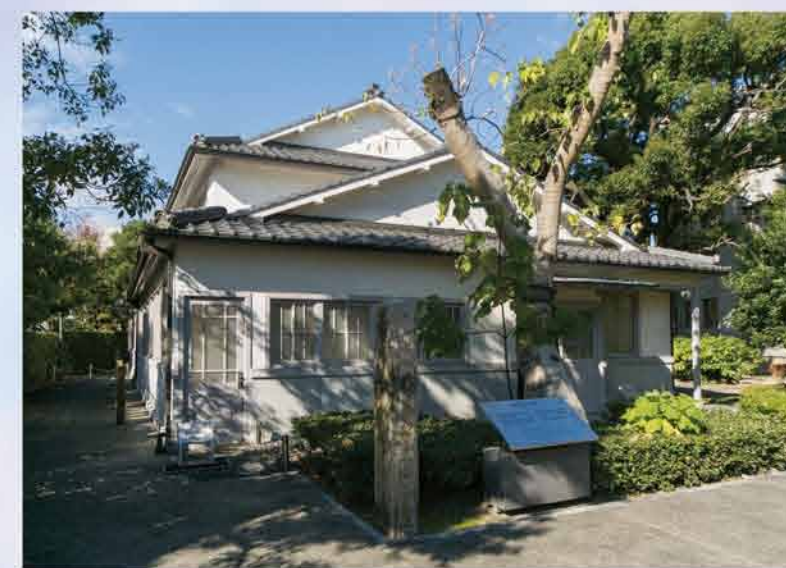
古い学校を思わせる2階建て木造建築の「豊田商会本社事務所」は1905年(明治38年)築。1994年、名駅から現在の地に移転・修復
