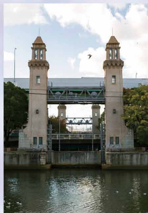
鉄筋コンクリートの人造石流し出して一部花崗岩を使用。新幹線からも見えると話題に
