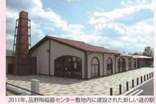
2011年、品野陶磁器センター敷地内に建設された新しい道の駅
