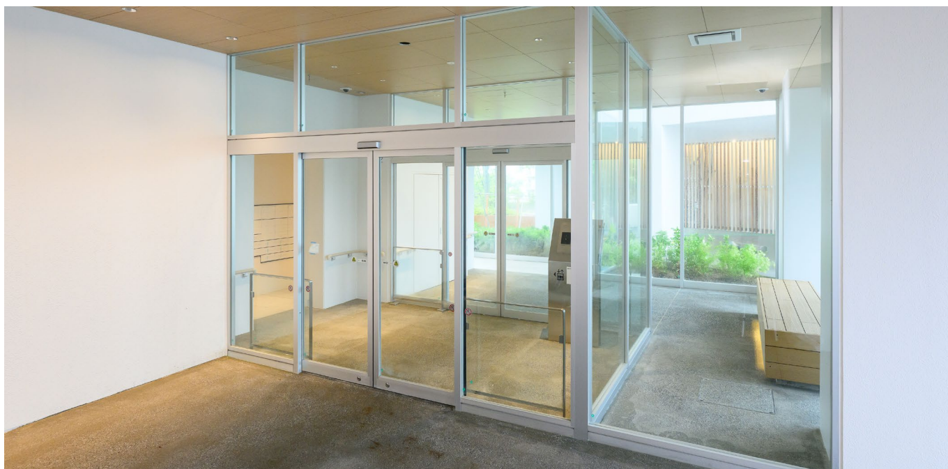
ピロティ・風除室
