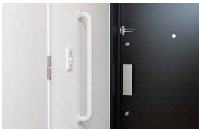
玄関周り(手すり・人感センサー付LED玄関灯)
