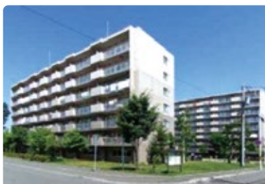
建替後の新木の花団地1-1、1-2、1-3号棟
