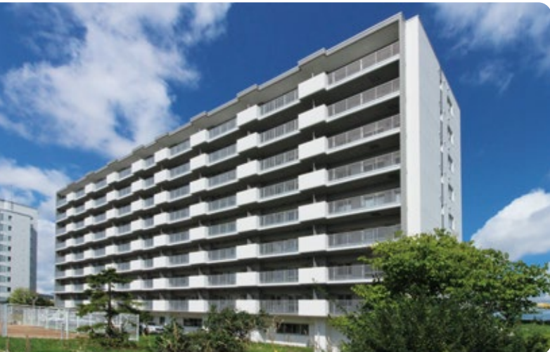
外観(南側から撮影)
