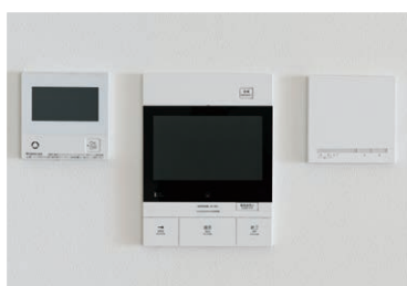
給湯リモコン・住宅情報盤・床暖房スイッチ
