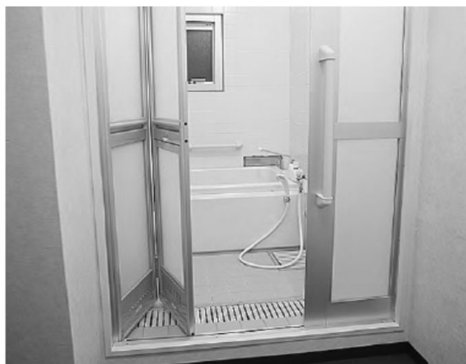
浴室の出入口扉には扱いやすいアルミ製折戸と手すりを設置しています。
