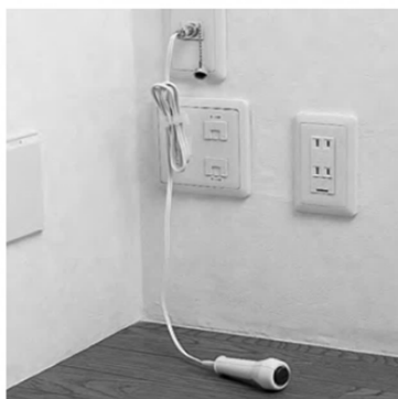
居室(1室)に設置される 緊急通報用の握り押しボタン
