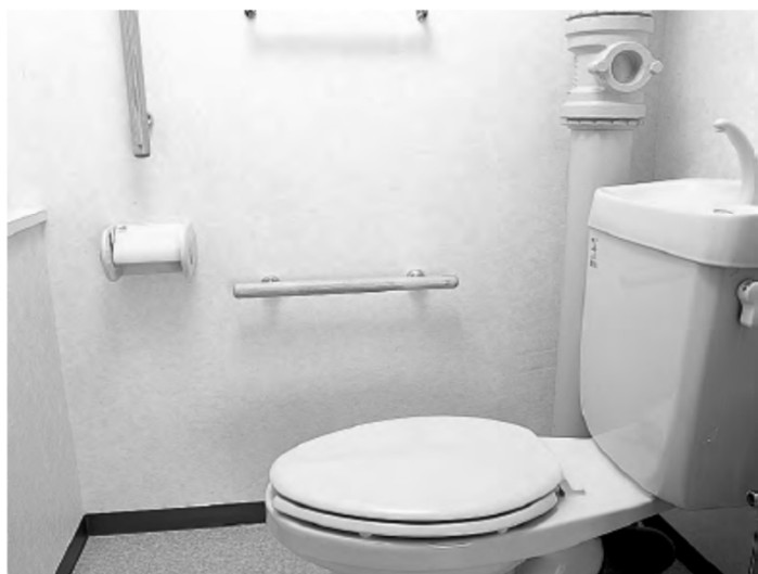
トイレに手すりを設置しています。
