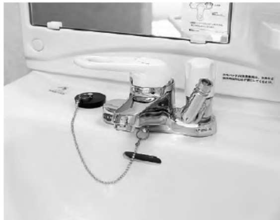
シングルレバー混合水栓で、温度と水量の調節が簡単です。照明のスイッチも大型にしました。
