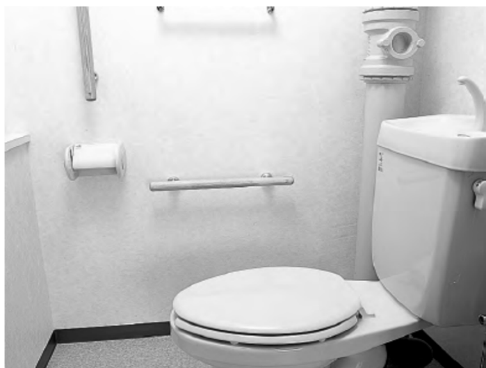
トイレに手すりを設置しています。
