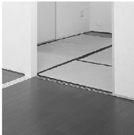
居室間やトイレの床の段差を解消
