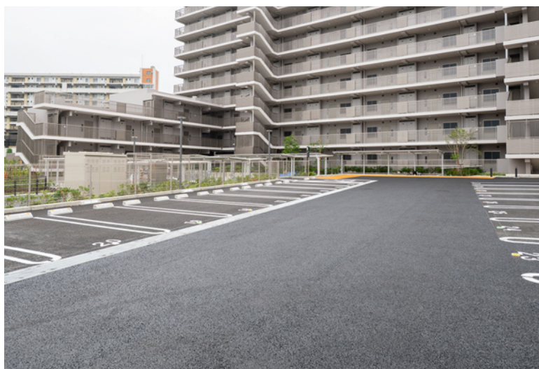
駐車場 (2-1-2号棟付近)
