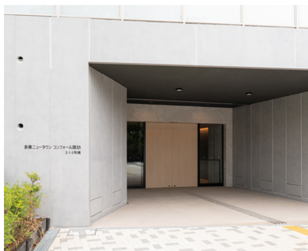
エントランスポーチ(B1F)
