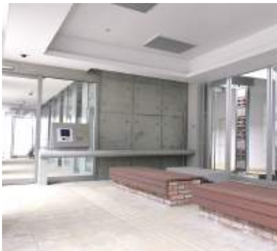
16号棟エントランスホール
