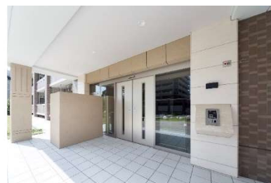
アーバンラフレ星ヶ丘 11 号棟
