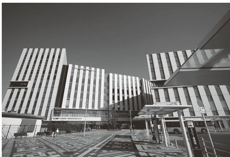
周辺の道路も完成してアクセスもスムーズになった 天空橋駅の上に位置するHiCity(羽田イノベーションシティ)。
