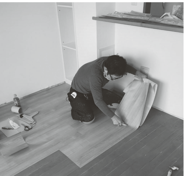
開発したシート状の床材は薄い素材なので使用の幅が広がる。
