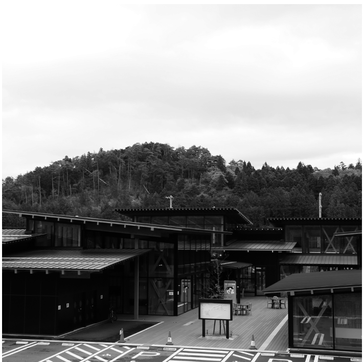
南三陸町生涯学習センターは、木のぬくもりが感じられ、陽の光を取り入れる明るいスペース
