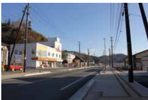
再建が進む県道沿いの様子（平成 29 年 12 月）
