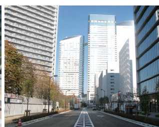
整備後の風景（無電柱化） 景観形成の観点から、まちの魅力の向上を図るため、無電柱化を行いました
