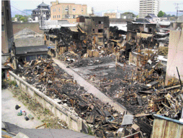
火災被災後の地区
