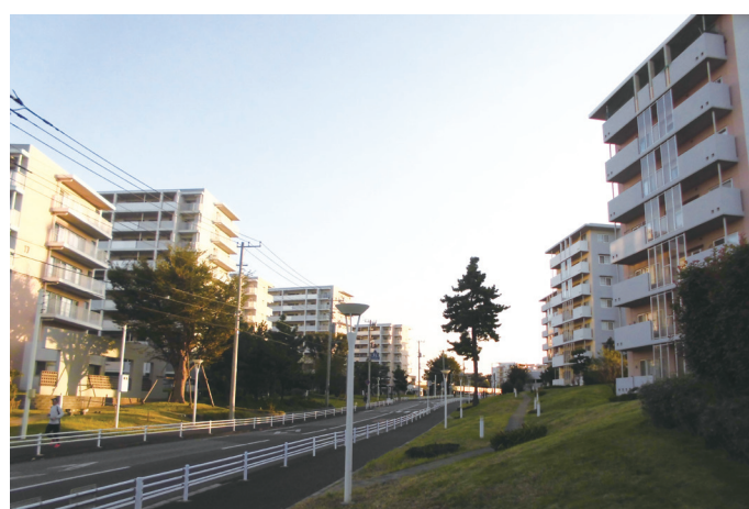
建て替え後の住宅。地形を生かして建設されている
