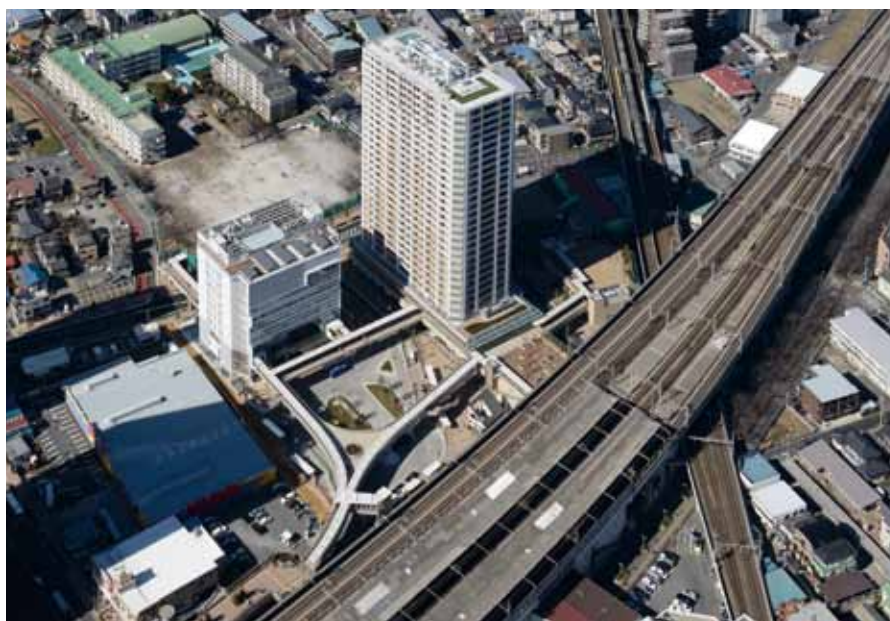
先工区整備後（平成 25 年 2 月）
