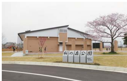
防災公園 既存建物を改修した備蓄倉庫
