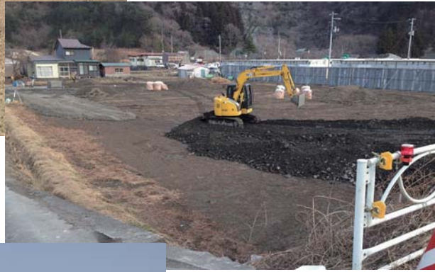
造成中（平成 26 年 1 月 29 日）
