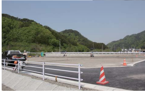
造成完了（平成 26 年 5 月 14 日）
