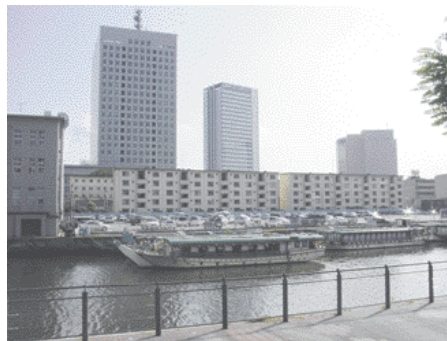
手前の中層棟が海岸通団地（平成 18 年）
