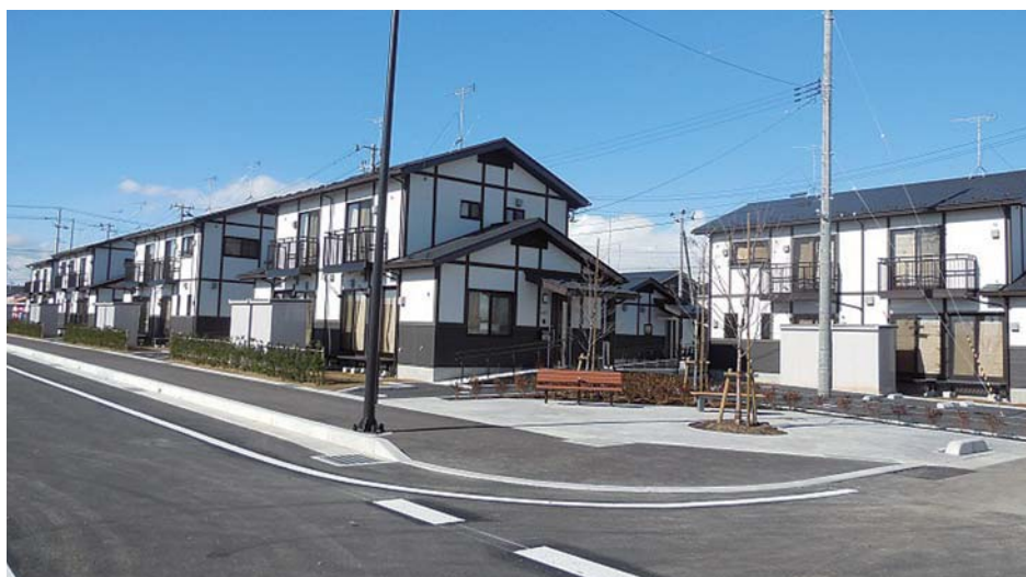
災害公営住宅第Ⅰ期完成 平成 26 年 11 年
