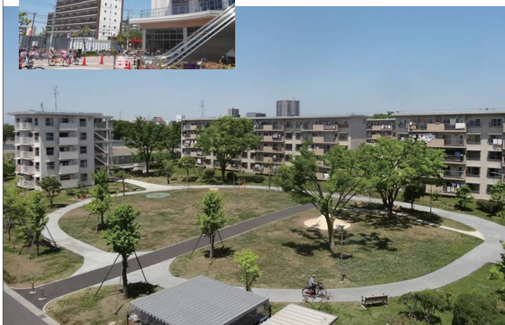
広場と改修後住棟 (27 号棟他)
