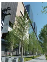
民間提案を取り入れた歩道整備 (H26.5)
