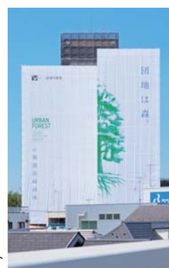
「団地は森。」の仮設養生シート
