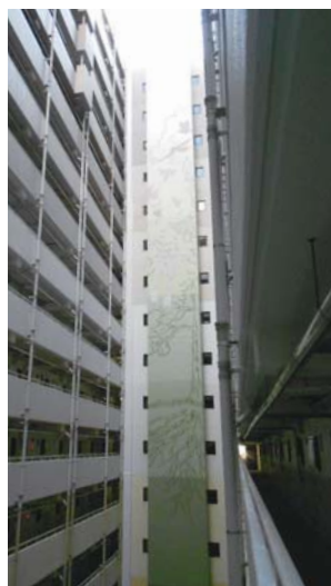
共用部のグラフィック塗装
