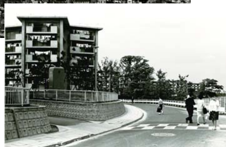
ポイント住棟のスターハウス
