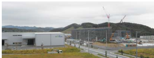
建設中の工場（今年 10 月撮影）
