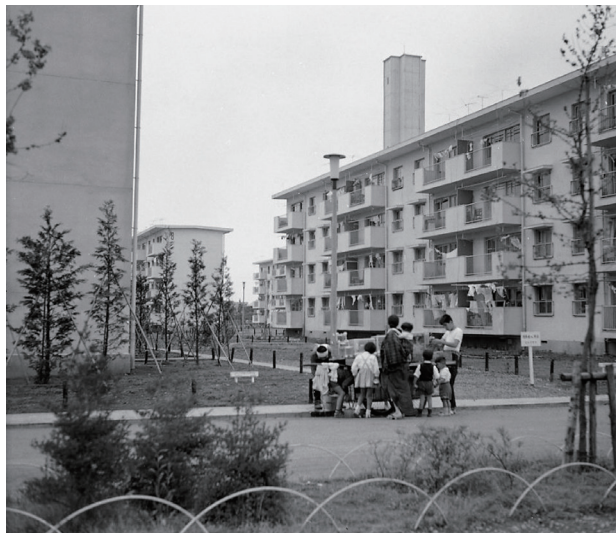
建設当時の久米川団地
