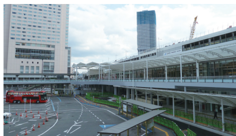
先行して完成したペデストリアンデッキ （平成 28 年 10 月）
