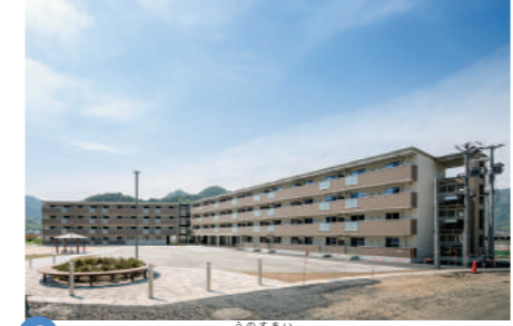
6 岩手県釜石市 鶴住住宅
