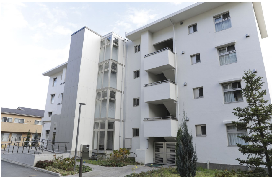
団地の南側には、地域の在宅介護・医療の拠点となる「日生ケアヴィレッジひばりが丘」がある。エレベーターを増築し、住棟全体をバリアフリー化したサービス付き高齢者向け住宅は、常に満室だ。
