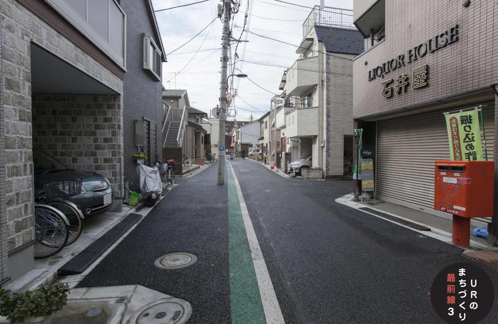
広域避難場所の荒川自然公園に向かう主要生活道路を6mに拡幅した。電柱の位置が元の道路幅を思い起こさせる。
