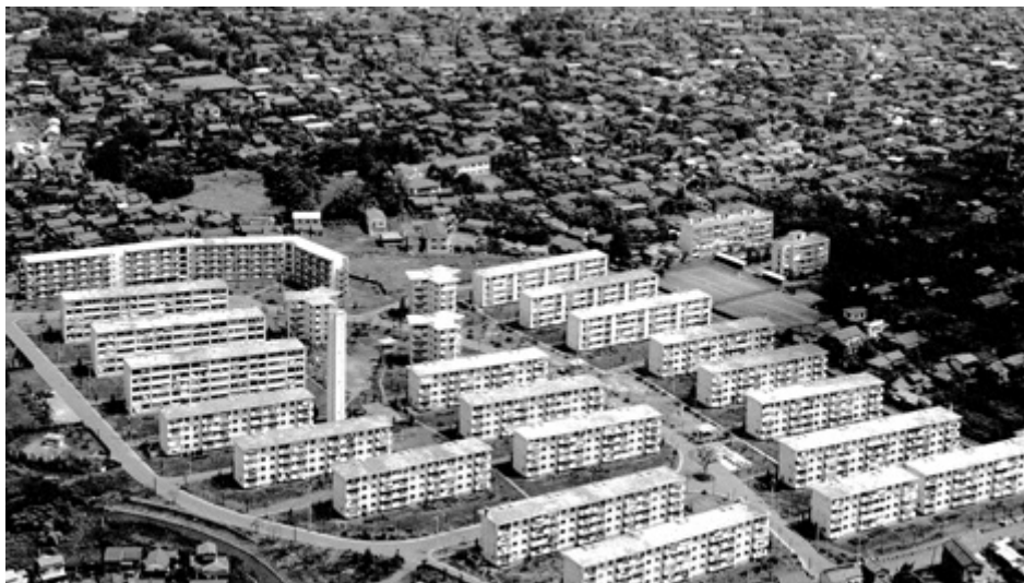
荻窪団地の空撮写真。当時木造が主流だった中であって、鉄筋コンクリート造の荻窪団地は、憧れの住宅だった
