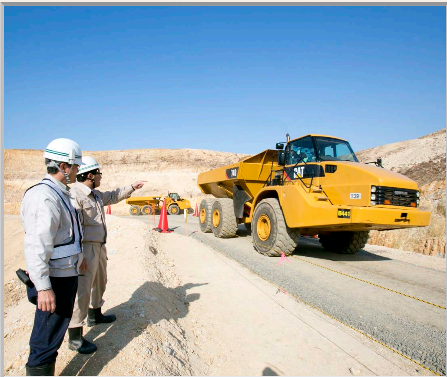
(宮城県東松島市の野蒜北部丘陵地区、写真: 的野弘路)
