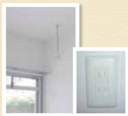
取り外し可能な物干し用金物(左)や、差し込み口に感電防止を目的とした遮断扉を付けたコンセント(右)も、うれしいアイデア
