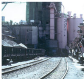
引き込み線もある大規模な工場だった 日立コンクリート(株)押上工場
