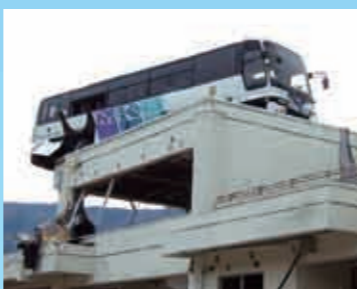
津波に流されて公民館の上に打ち上げられた観光バス(宮城県石巻市)
