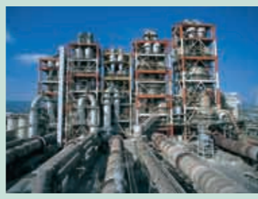
日本のセメント生産は世界で最も熱効率がよく、極限に近づいている。(写真は三菱マテリアル九州工場のNSPキルン、三菱マテリアル(株)提供)
