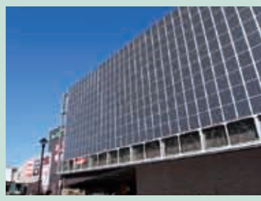
イオンレイクタウンの壁面や屋根などに設置されているソーラパネルの合計面積は、国内商業施設最大の4,000㎡。
