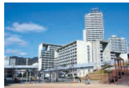
脇の浜 機構エリア全景
