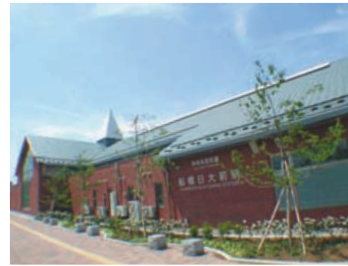
地区のシンボリック存在の船橋日大前駅東口駅舎
