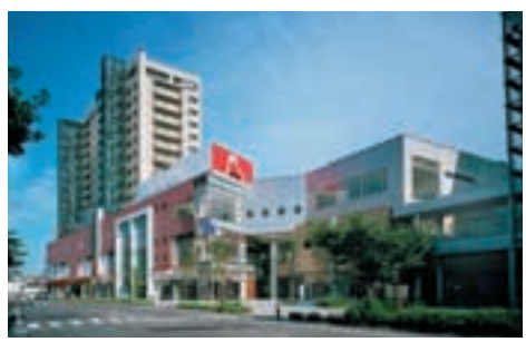
防府駅でんじんぐち地区(山口県防府市)
