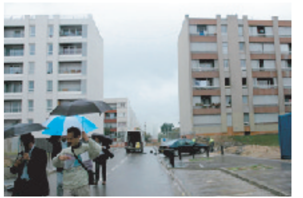
フランス パリ郊外の団地再生 階段室一階段分を減築し、その間に道路を通す(右が改修前 左が改修後)
